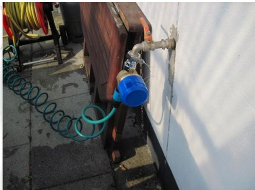
Der Zapfhahnzähler muss so verplombt werden, dass ein Abmontieren des Zählers ausgeschlossen ist. Der Zähler verbleibt somit ganzjährig an der Entnahmestelle. Die Plombe wird erst wieder bei Austausch des Zählers nach Ablauf der Eichung entfernt.
